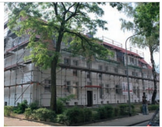
Wärmedämmmaßnahmen und Anbau von Balkonen in der Allensteiner Straße
