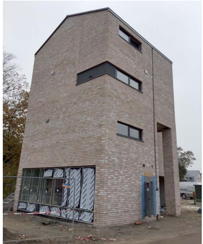
Alles eine Frage der Technik: Der zentrale „Turm“ versorgt alle Gebäude mit umweltfreundlicher Fernwärme.
