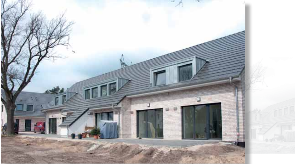
Die ersten Mieter sind im Lindenhof bereits eingezogen.
