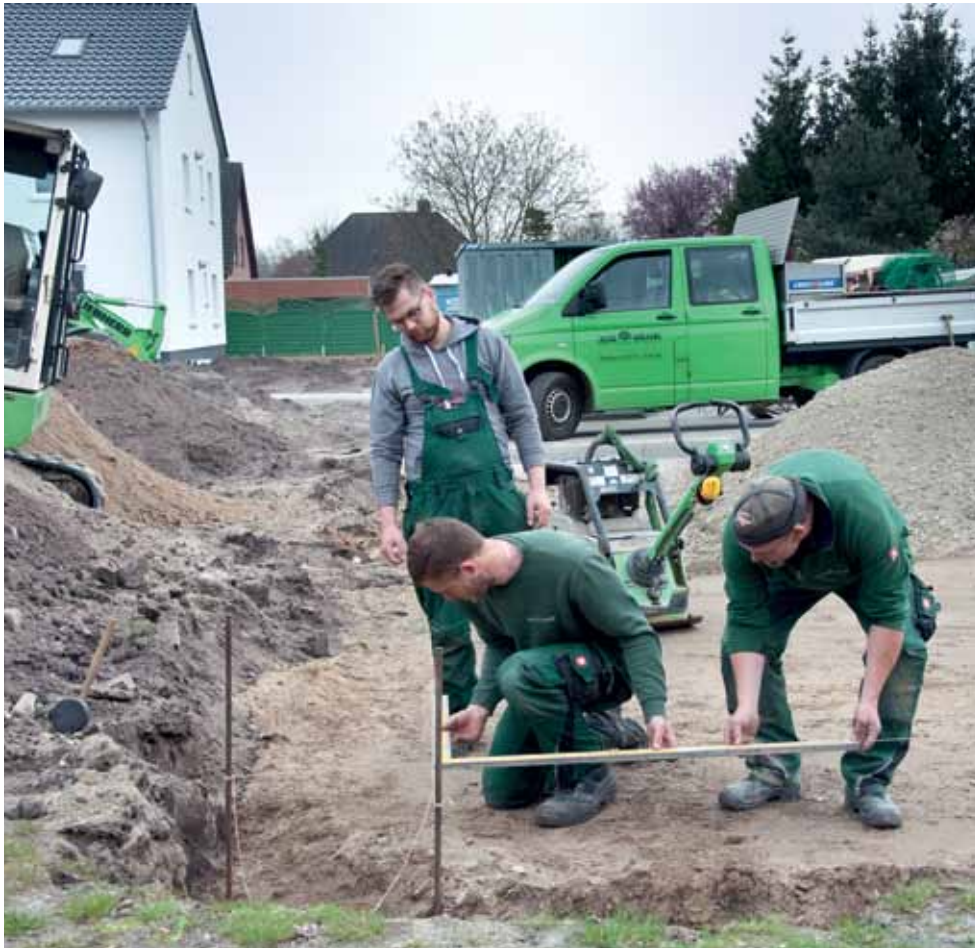
Jesse und Wrann Services GmbH: Pflasterarbeiten
