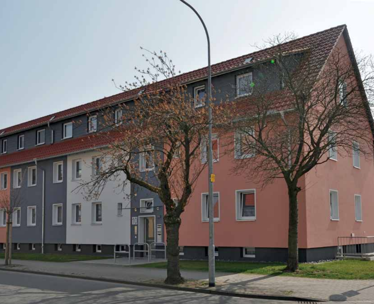
Herzog-Ernst-August-Straße: energetische Gesamtanierung
