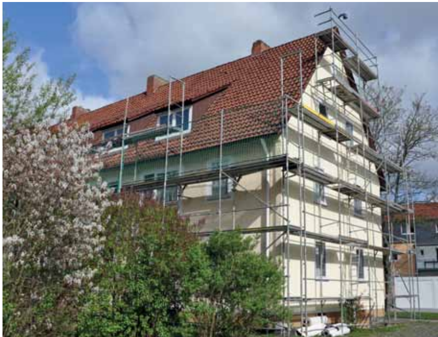
Sanierungsarbeiten in der Elbinger Straße
