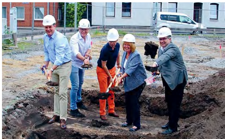
Die Erdarbeiten beginnen: Beim offiziellen Spatenstich folgte auf Handarbeit bald schweres Gerät.
