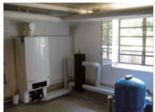
Auch alle hydraulischen Komponenten, Pumpen, Wärmetauscher, Manometer, Stellglieder und die Heizungsanlagen wurden neu installiert.
