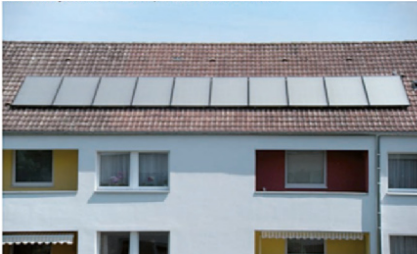
Auf den 10 Wohngebäuden der GWG wurden jeweils 10 Sonnenkollektoren montiert.
