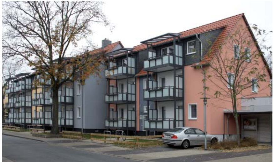
Gut gedämmt: Optimierte Energiebilanz in der Herzog-Ernst-August-Straße 11 – 15 vorher und nachher
