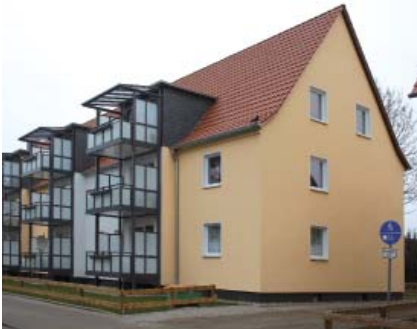
Energetisch und optisch auf neuestem Stand: Herzog-Ernst-August-Straße 3 – 5 vorher und nachher
