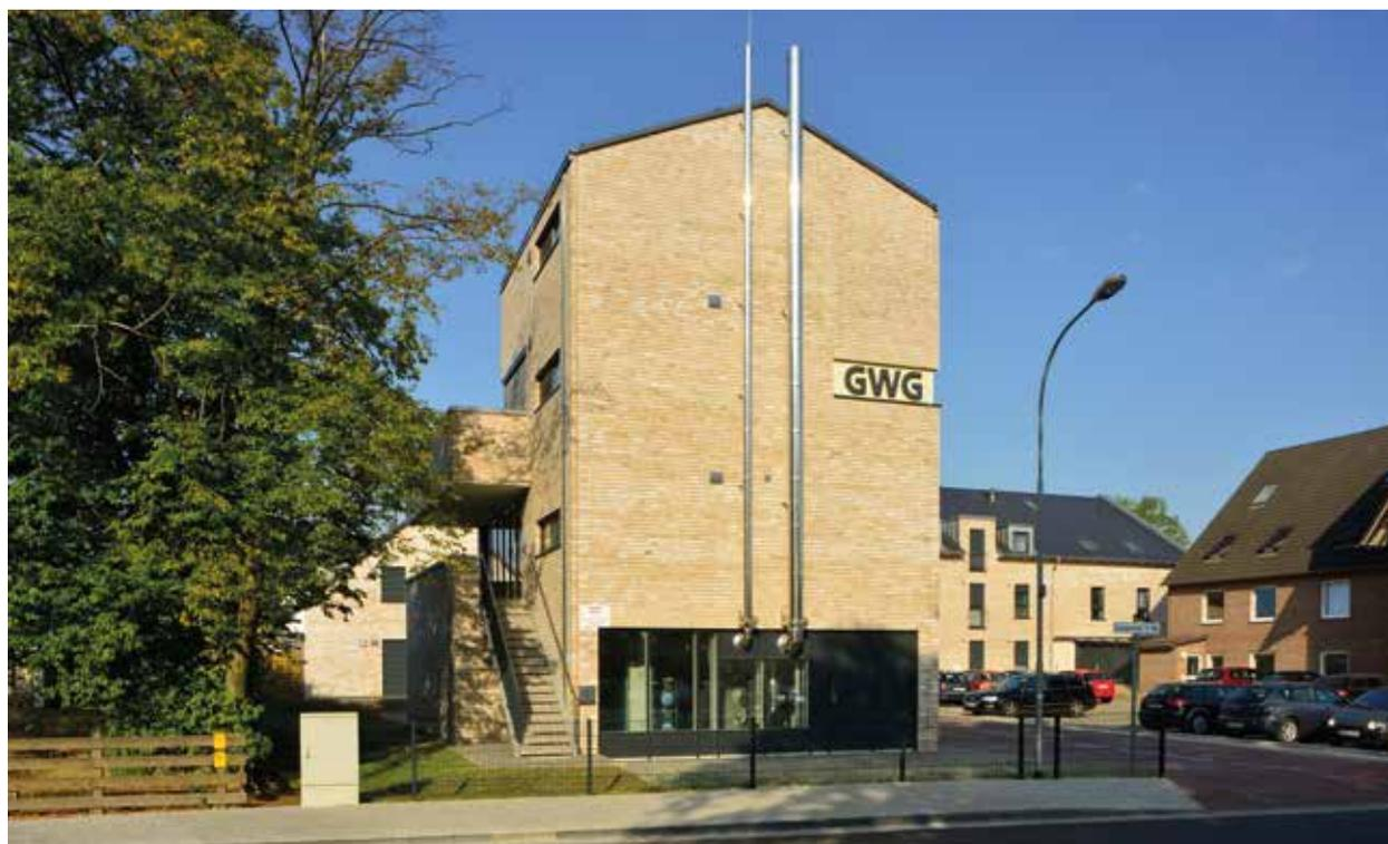
Das hocheffiziente Erdgas-BlockHeizkraftwerk im Versorgungsturm kann durch eine Glasscheibe besichtigt werden. Von hier wird das gesamte Quartier mit Strom und Wärme versorgt.
