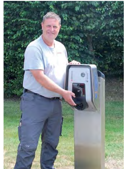
Jetzt auch oberirdisch: Unser Quartiermanager Roland Riedl präsentiert die neugeschaffene E-Ladestation neben dem Energieturm.
