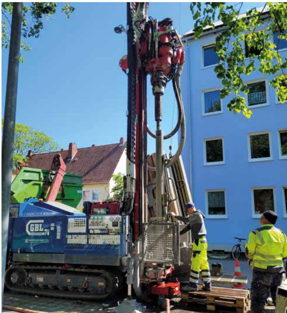
Bohrung für Erdwärme am Herbert-Trautmann-Platz
