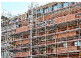
Blick auf die Baustelle eines Mehrfamilienhauses mit neuen Wohnungen.
