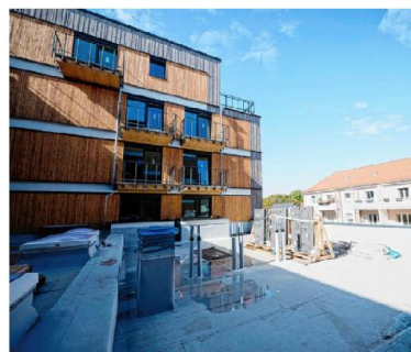
Blick in den Innenhof des in Holzbauweise errichteten Gebäudes. Das Dach soll noch begrünt werden.
